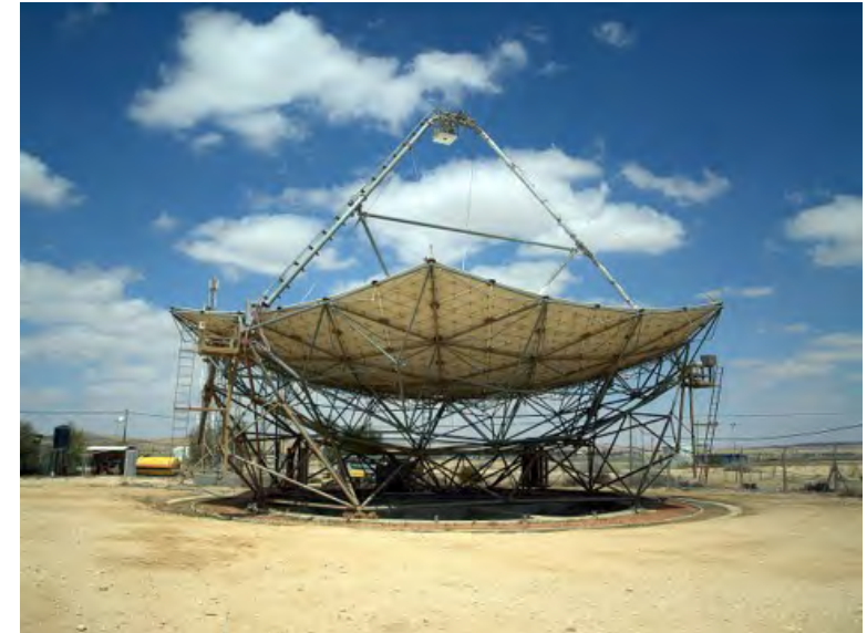
Uno dei più grandi paraboloidi nel mondo allestito presso il Ben-Gurion National Solar Energy Center in Israele.
