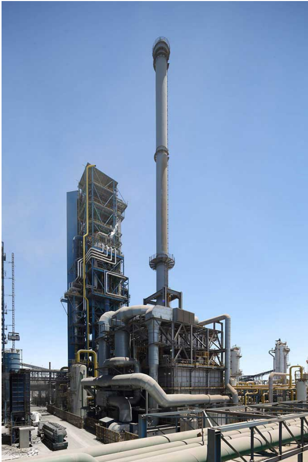
Fig.28 Tipico reattore DRI ( quello in secondo piano)
