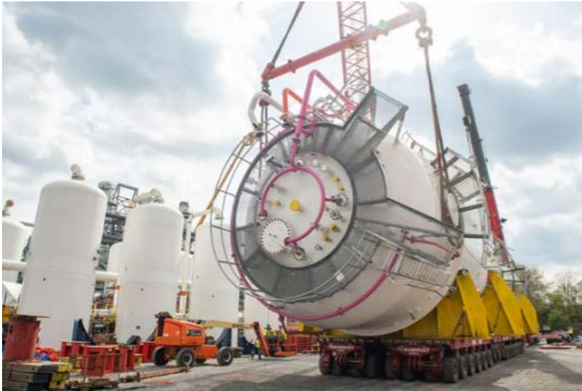
Figura 19 Bioreattore per la conversione di BF off-gas a etanolo
