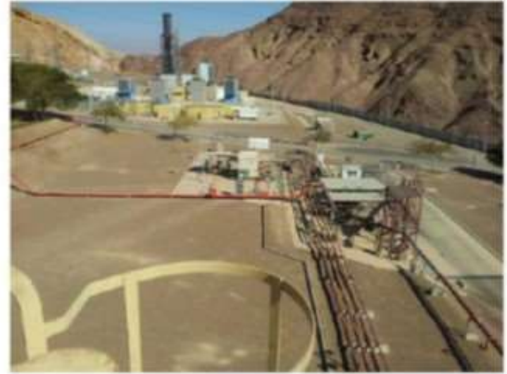
Conversione di centrale elettrica con turbina a gas da alimentazione diesel a metanolo (Eilat, Israele)
